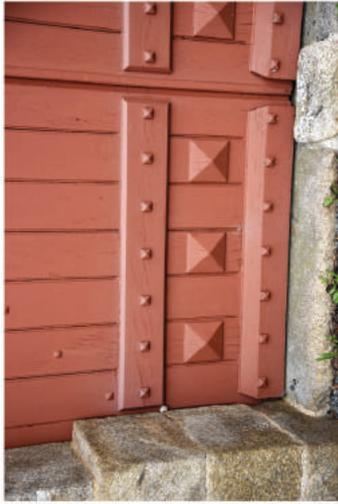
La porte en bois a été remplacée en 1955, fabriquée par le menuisier briacé Joseph Mazévet. Le montage a été effectué à l'ancienne, c'est-à-dire la menuiserie est solidarisée par des pointes à tête diamant.
