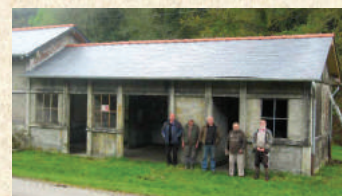
Pose de la charpente et des ardoises sur le reste du bâtiment.
