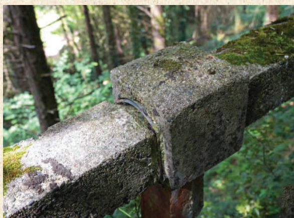
La rambarde longe le cheminement des rails.
