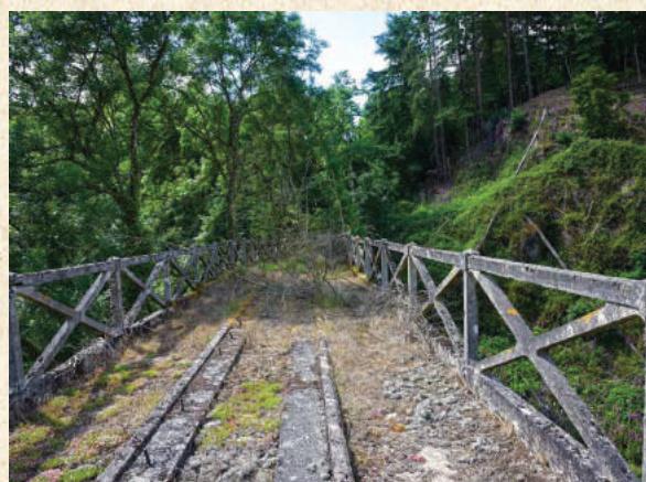
Bout du viaduc à la limite de Saint-Adrien et Coadout.
