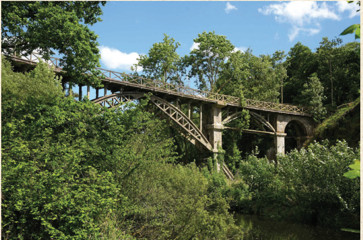
Le majestueux viaduc (1922/1938).
