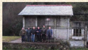
Pose de la charpente et des ardoises sur la partie « magasin ».
