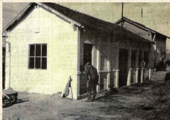
Gare avant démolition le 24 janvier 1985.
