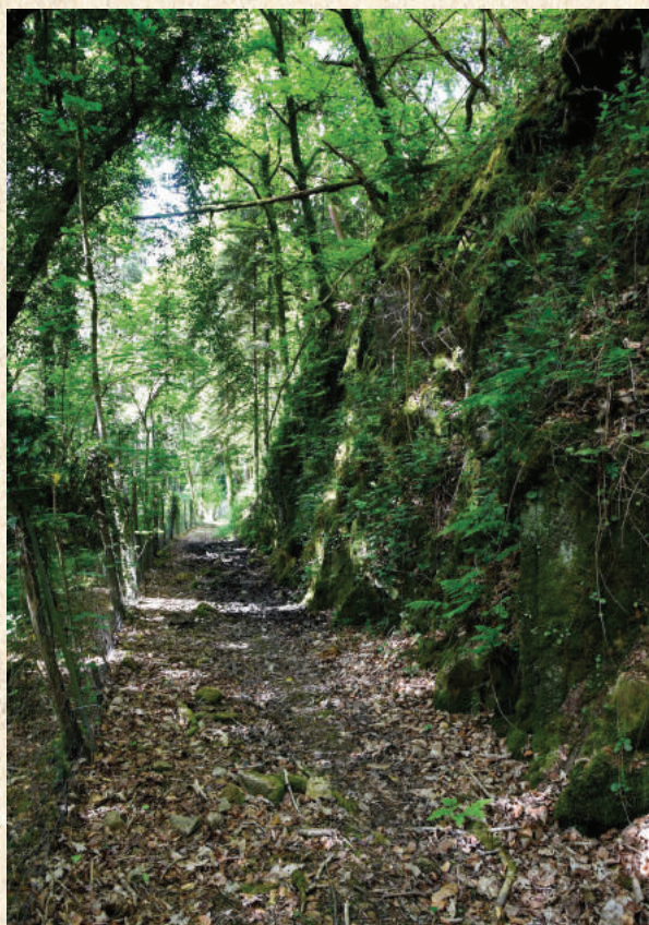
La roche a été taillée pour la construction de la voie. Un forgeron travaillait sur le chantier. Les outils devaient être affutés et réparés sur place.
